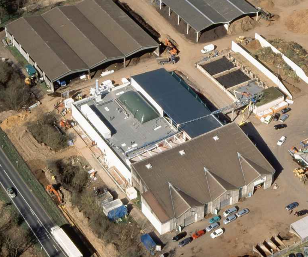
Aus der Vogelperspektive – die neue Vergärungsanlage am Kompostwerk
