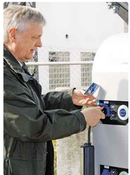
An den Solartankstellen am ROB lassen sich Elektromobile laden
