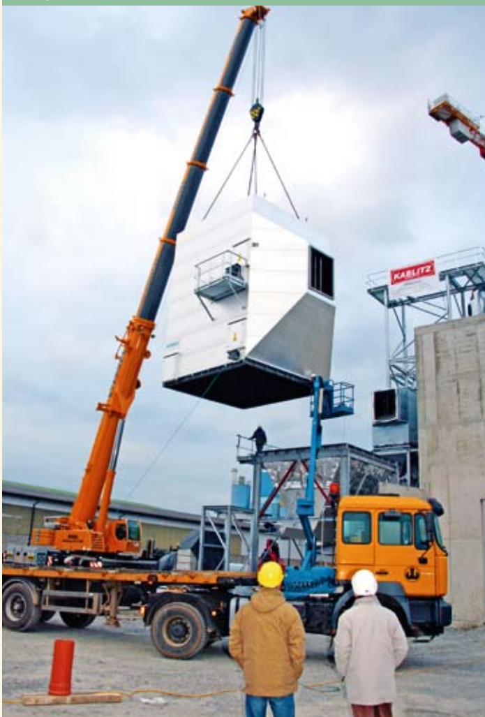
Montage des E-Filters
