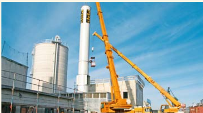
Montage des Abluftschornstein des Trockners
